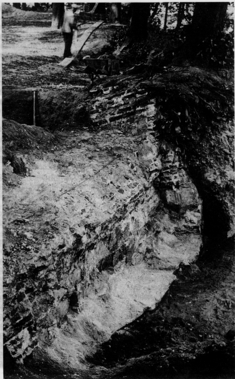
Start ontmanteling ringmuurfundament achter Barbarossa-ruïne in 1943, t.b.v. aanleg tweede bunker (fotocollectie Gemeente Archief Nijmegen)
