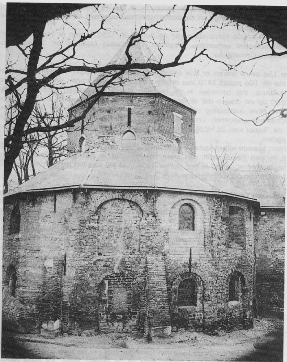
Noordzijde St. Nicolaaskapel na - voorzichtige- restauratie door Weve 1904-1906 (foto is voorzien van het handschrift van Weve)
