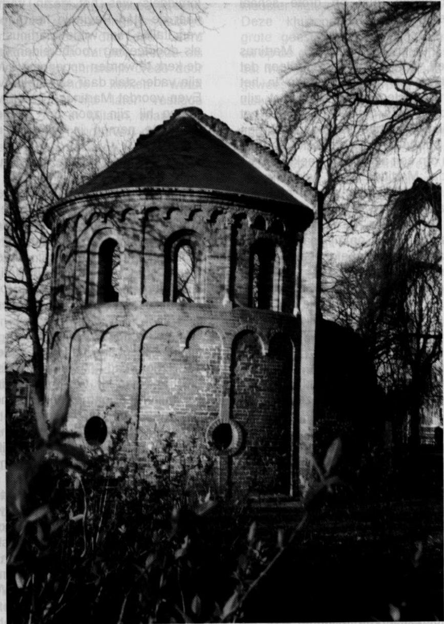
Achterzijde Barbarossa-ruïne. Het leidendak is door ir. J.J.Weve aan het begin van deze eeuw gereconstrueerd (foto: M.Vollebregt)
