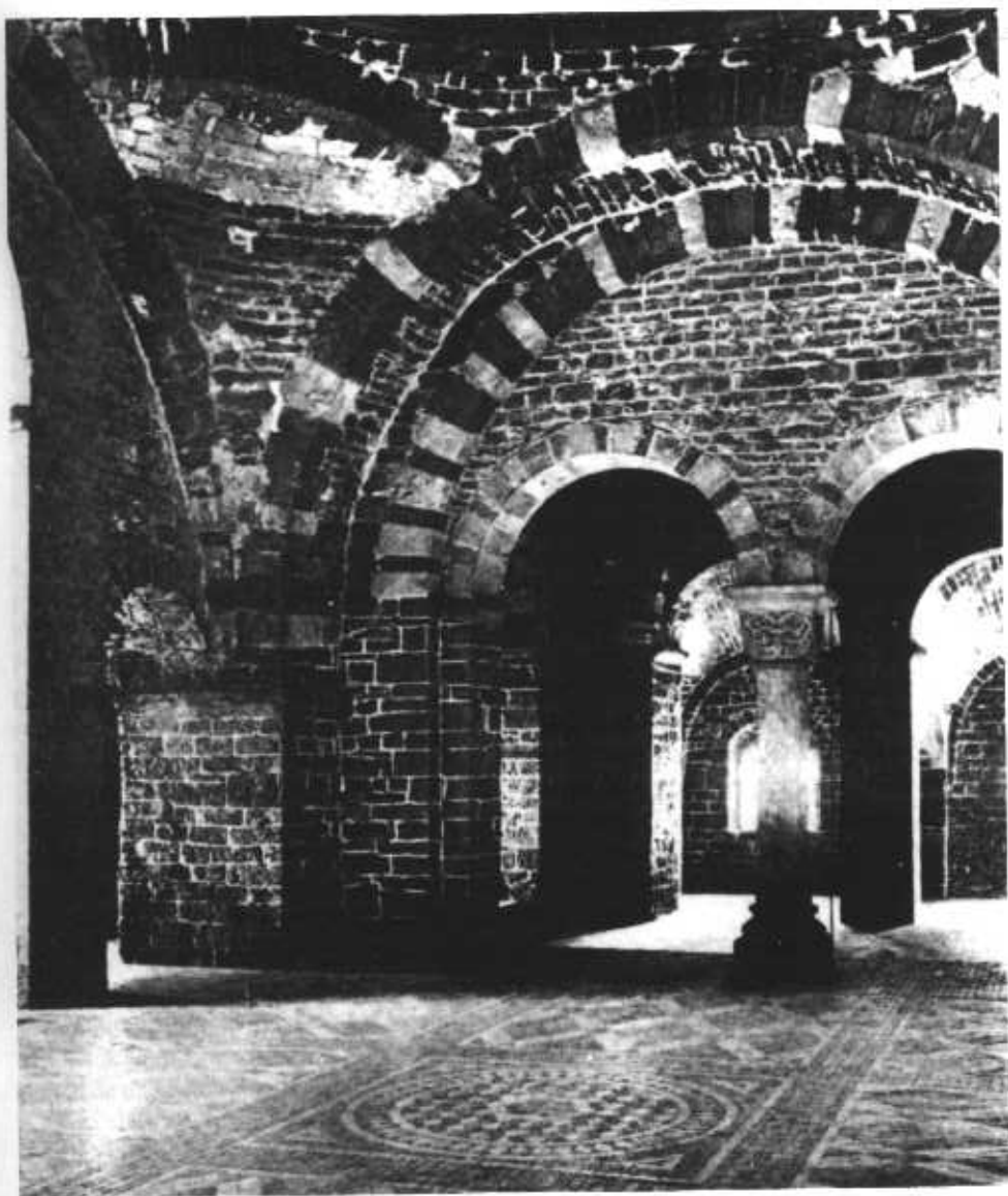
De vroeg-romaanse zg. 'Keizerzaal' in de St. Servaas te Maastricht. Ook hier een rondboog bestaande uit afwisselende stukken tuf- en baksteen.
