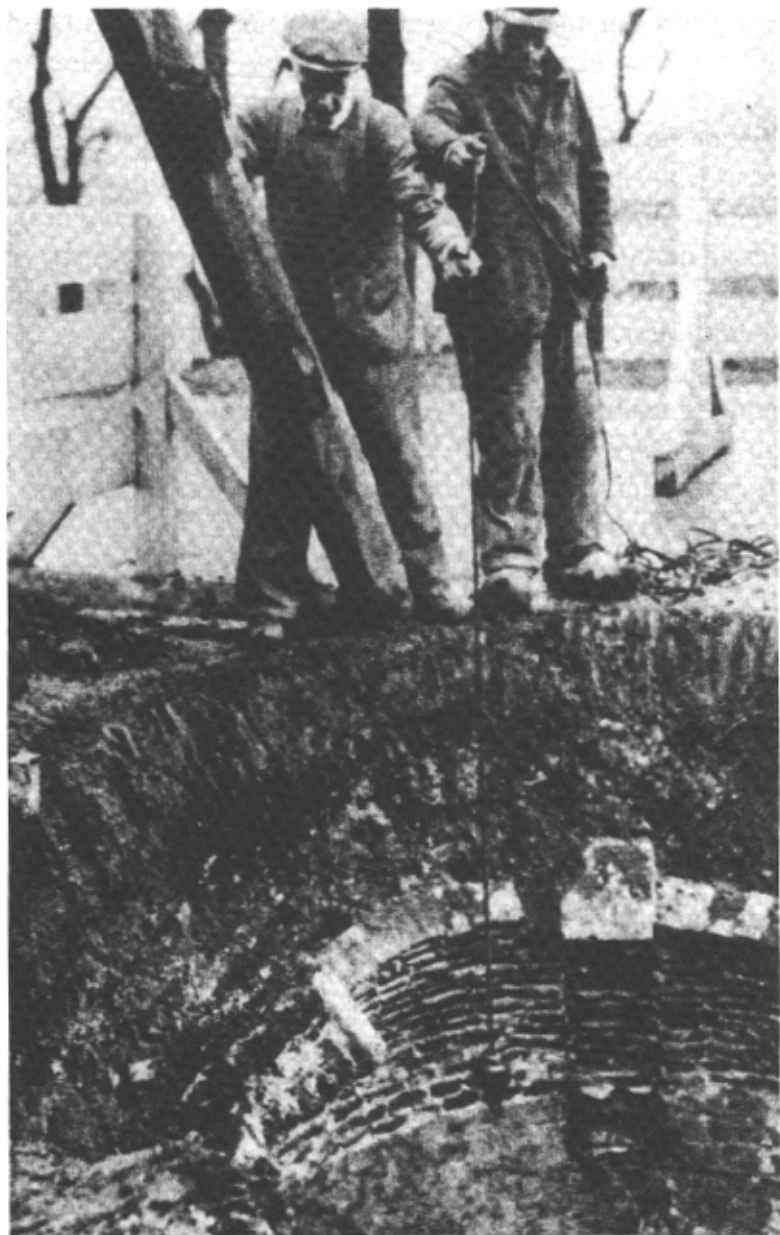
Werklieden met schietlood boven de tufstenen waterput met bakstenen gewelf in 1941. Fotocollectie Antoon Janssen.
