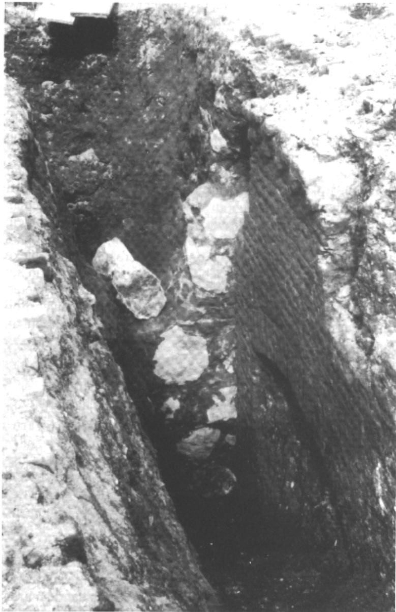
Het fundament van de ophaalbrug (Foto: J.J.Weve, 1911).
