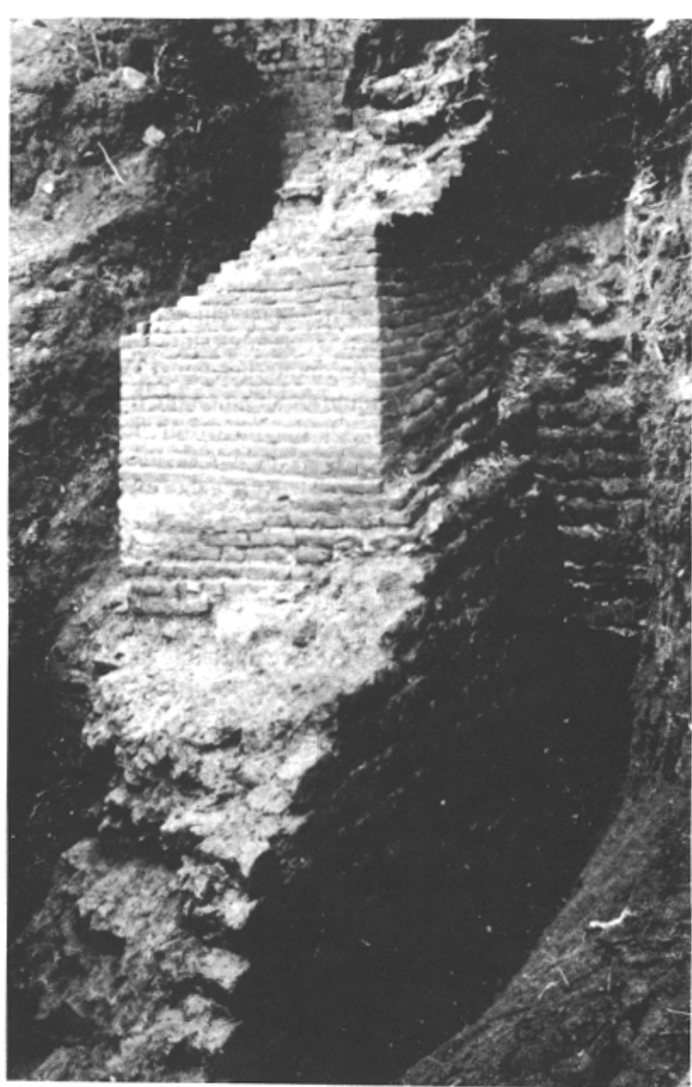
Opgraving steunbeer en fundament van de waltoren (Weve).
