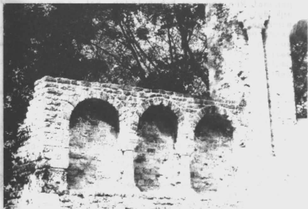
Detailfoto van de koornissen in de noordwand.
